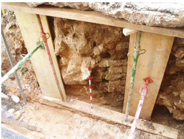
Foto 3. Vista dels murs UE 4 i UE 5.
