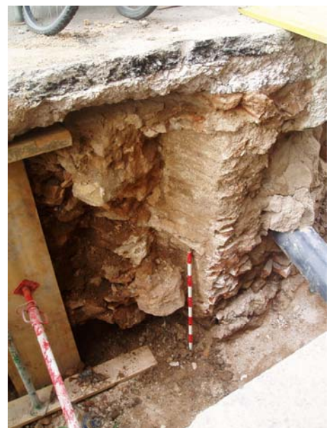
Foto 4. Vista del mur UE 6.
