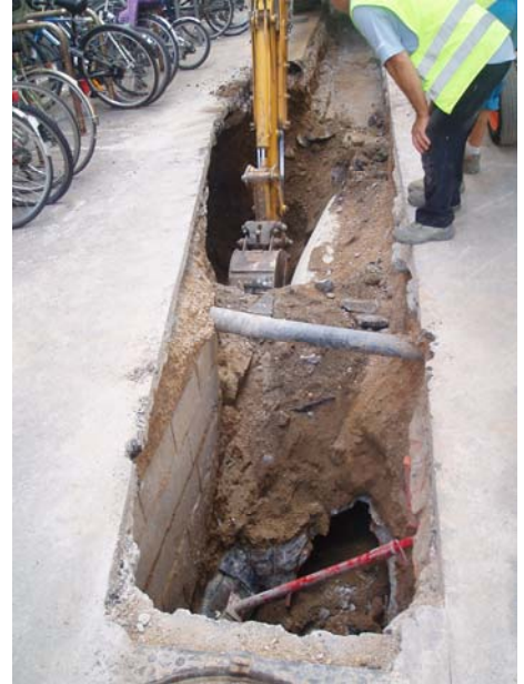
Foto 2. Realització mecànica de la rasa.
