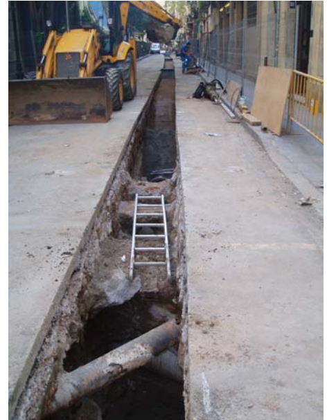
Foto 10. Vista del tram final de la Rasa 1. Vista des del NE
