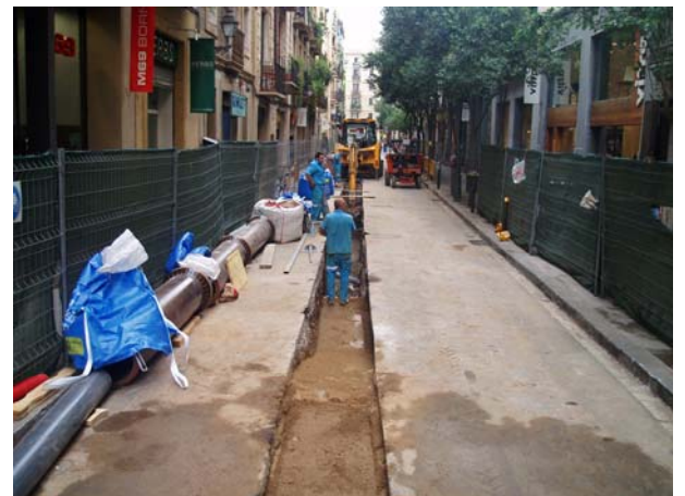
Foto 8. Realització de la rasa, al seu tram central.
