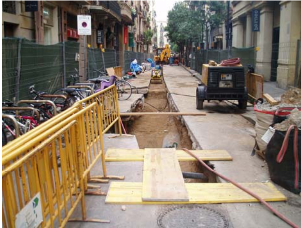
Foto 13. Treballs de rebliment de la Rasa.
